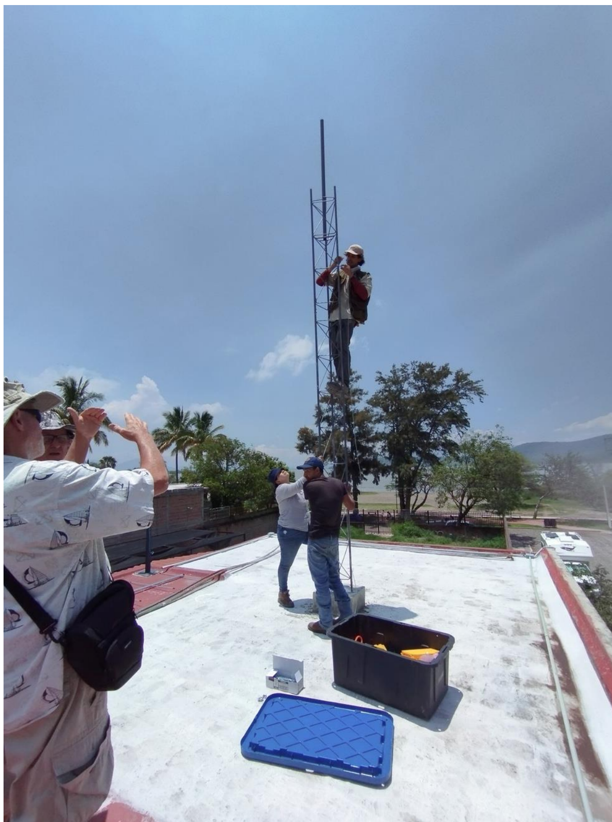
Colocación de cable de retenida
