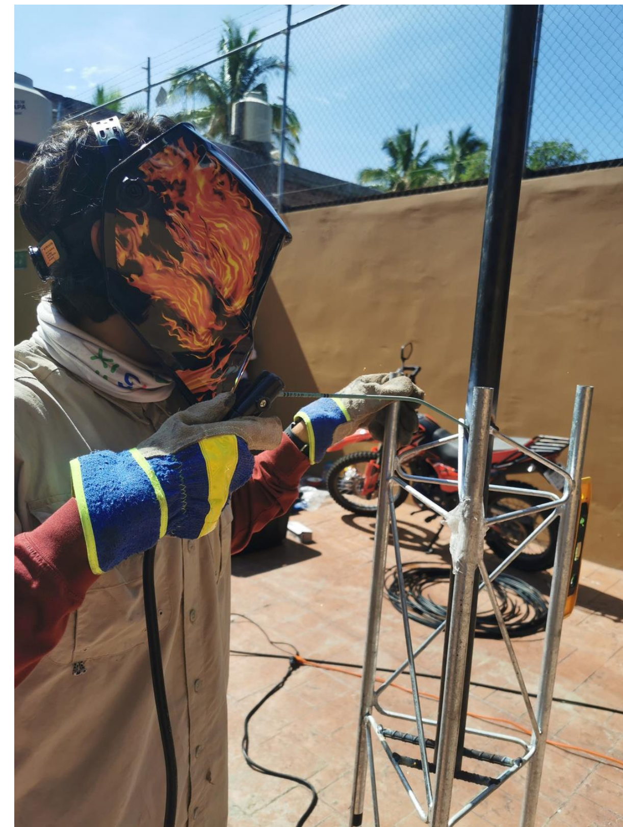
Colocación de copete
