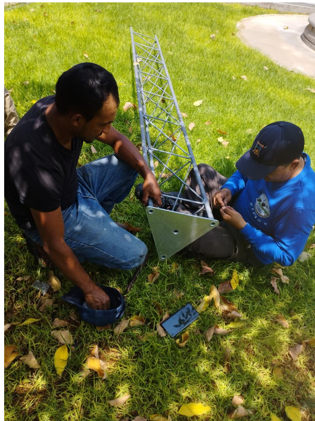
Colocación de base
