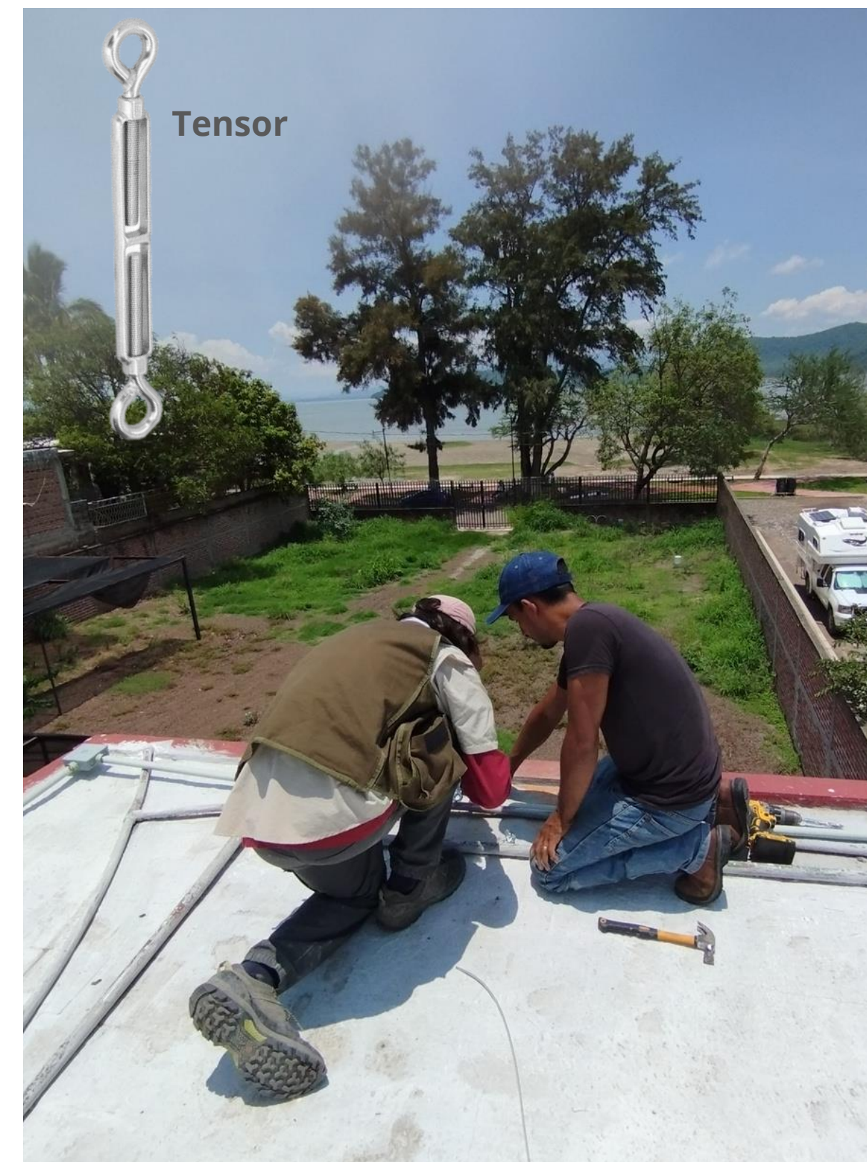
Tensado de cable de retenida
