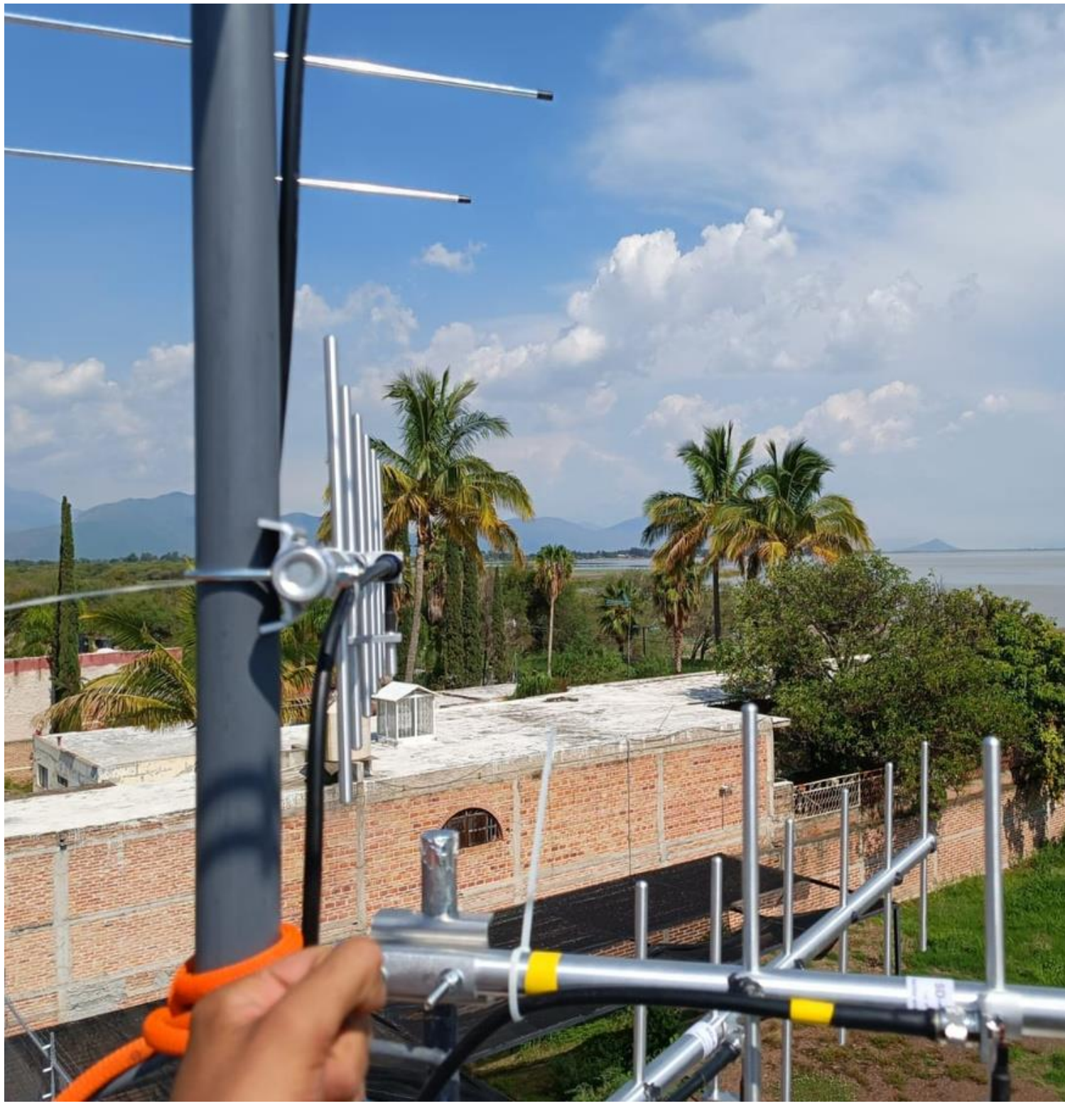
Instalación de cable coaxial
