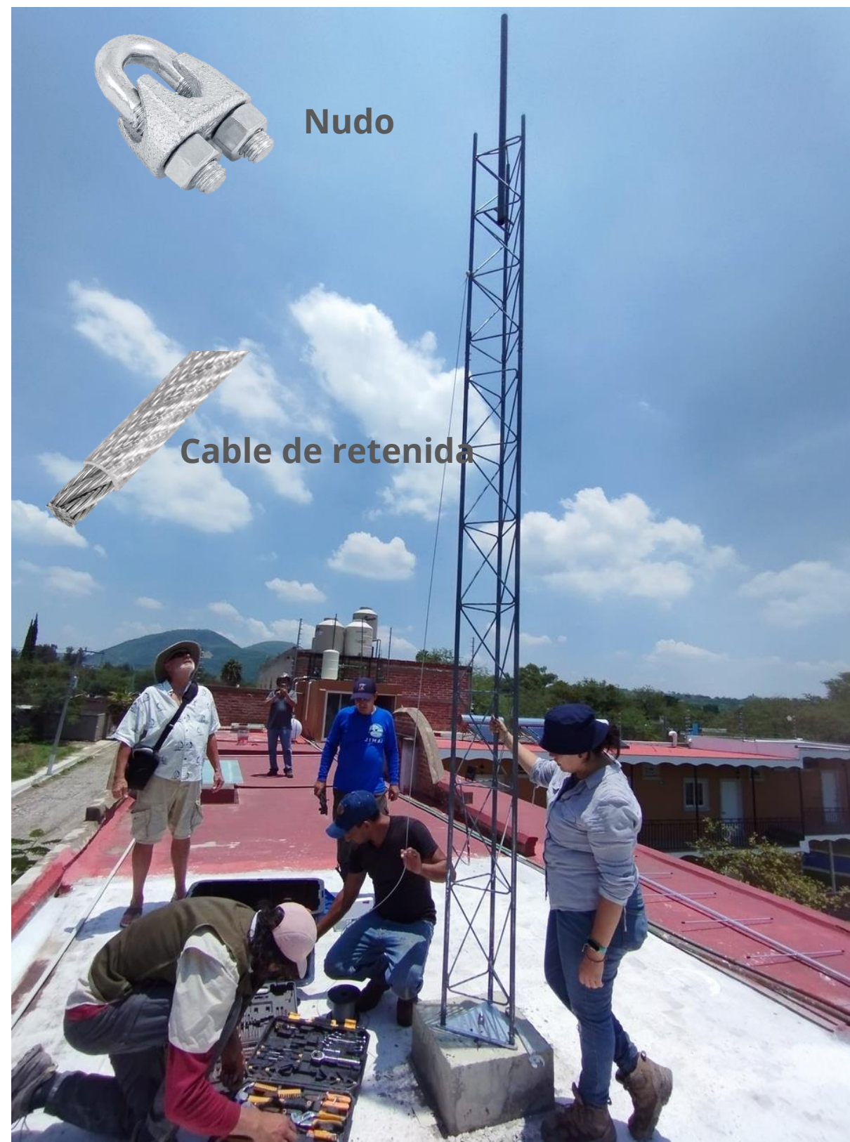
Tensado de cable de retenida
